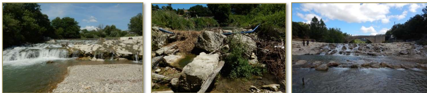
→ Exemple d'ouvrages présents sur le bassin de l'Ouvèze et étudiés par l'étude
