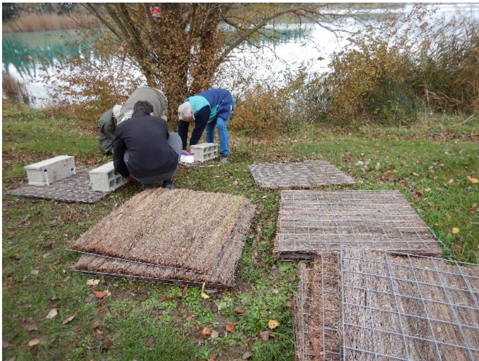
Construction des frayères artificielles avec les AAPPMA
